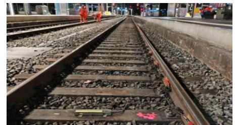
Gleisüberwachung mittels Amberg TrackControl
