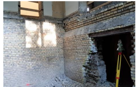
Absteckung im Gebäude
