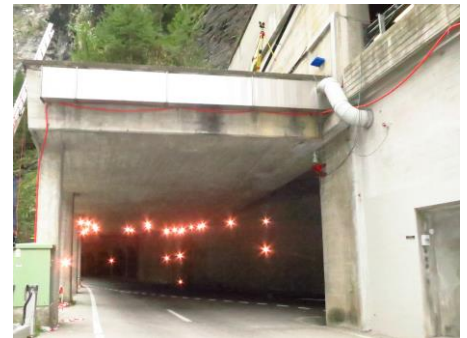
Einfahrt Steinschlaggalerie H13
