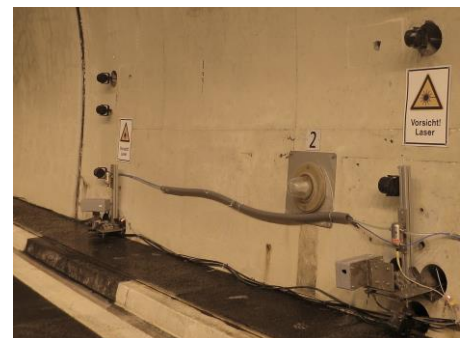
Installation Laserdisto und Schlauchwaagen im Autobahntunnel der A13
